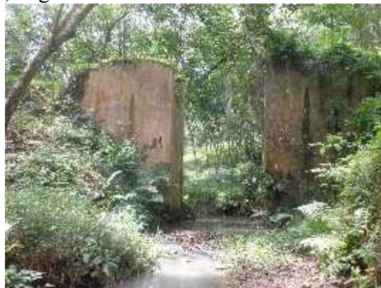
Gemetselde stenen brug in de smalspoorlijn naar het Bajah-kolenveld op West Java, juni 2012
